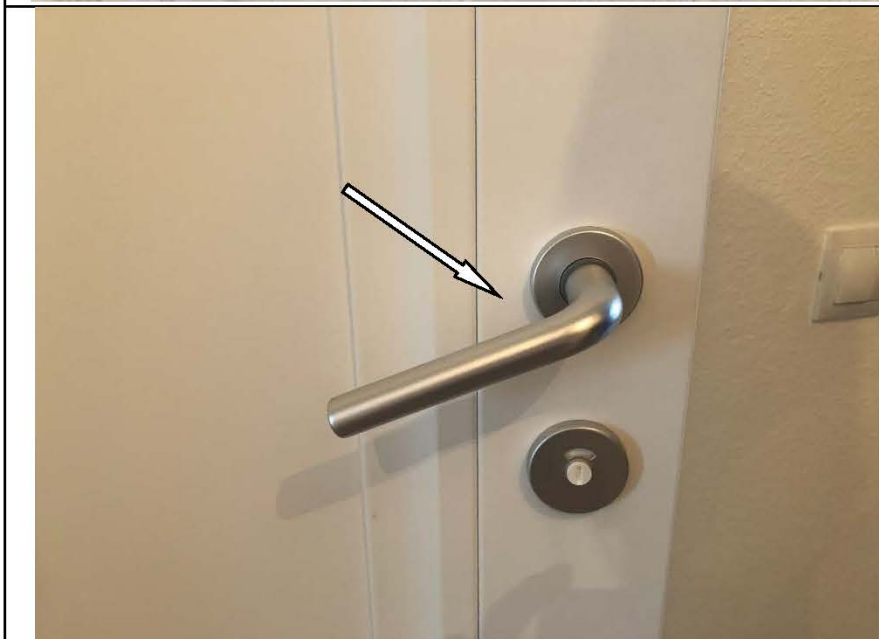
Фото №35. Дефект дверной ручки дверного блока в ванной комнате.
