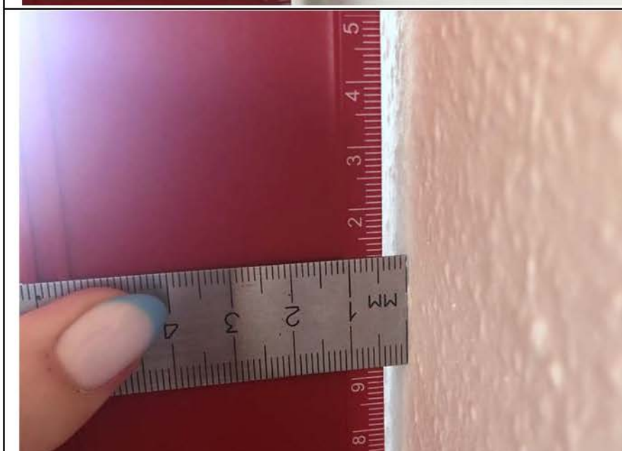
Фото №12. Измерение уровня стен детской в квартире.
