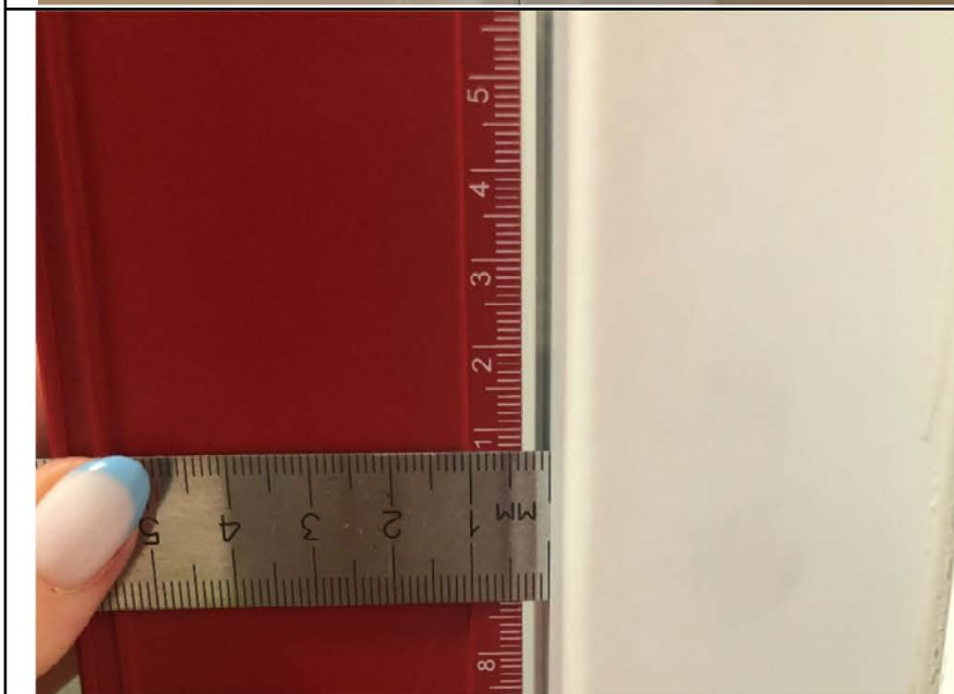
Фото №36. Измерение уровня наличника двери в ванной комнате.
