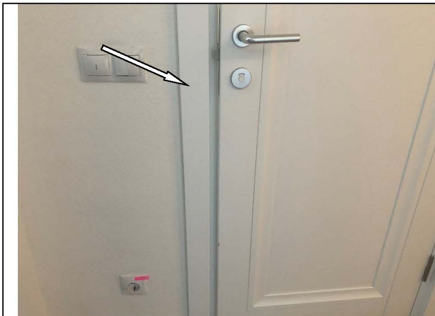
Фото №40. Дефект открывания и закрывания дверного блока в санузле.
