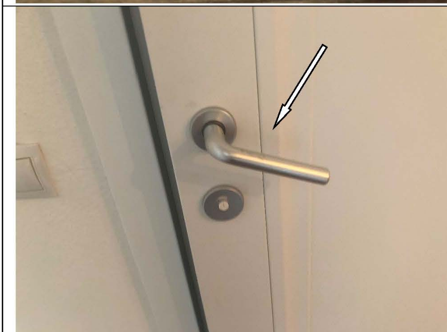
Фото №39. Дефект дверной ручки дверного блока в санузле.
