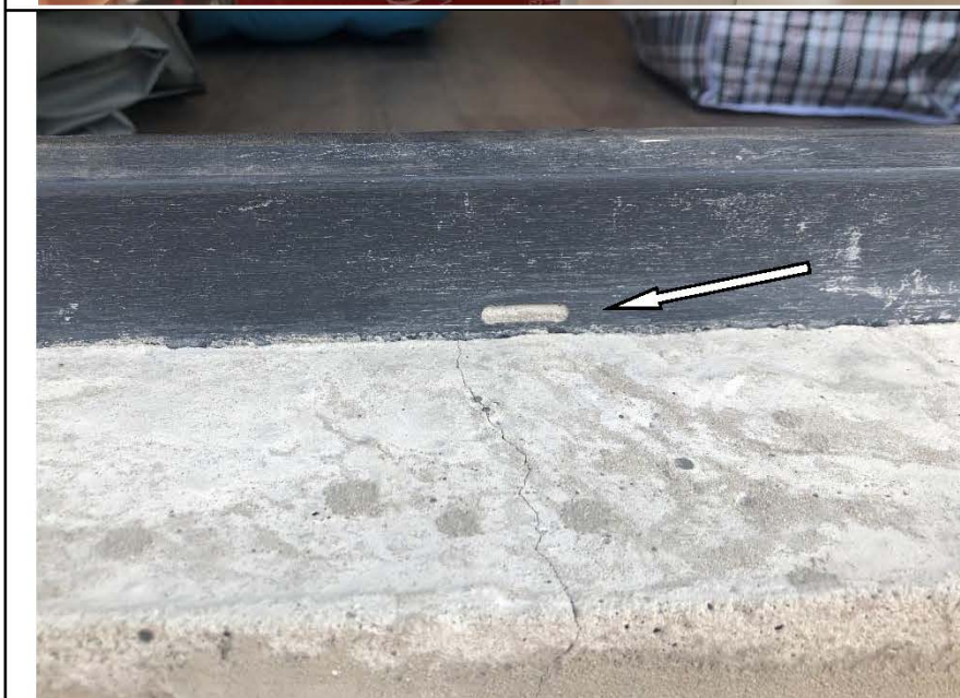
Фото №54. Отверстия в ПВХ профиле балконного блока с оконным для отвода воды в детской забиты цементным раствором.
