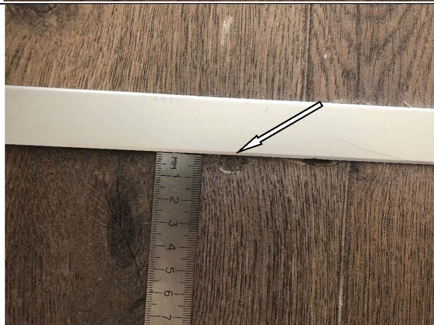
Фото №57. Дефект напольного покрытия коридора.
