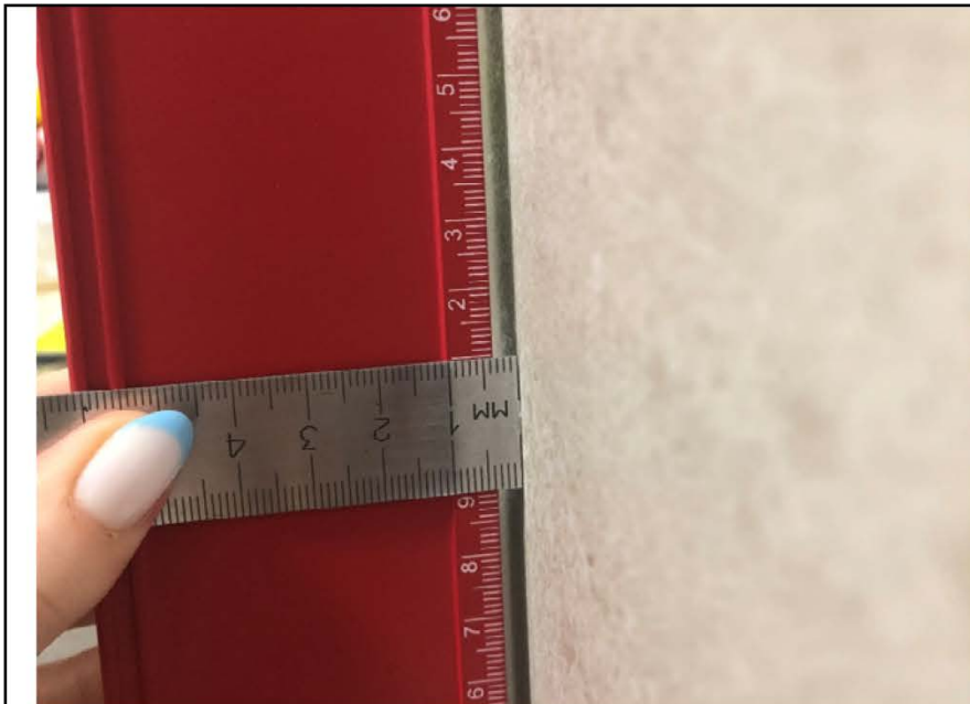
Фото №13. Измерение уровня стен санузла в квартире.
