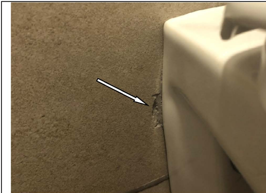
Фото №43. Отбитости настенной плитки в санузле.
