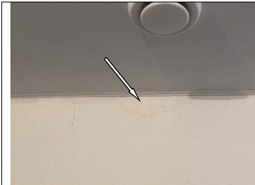
Фото №31. Следы от заливия на стене в кухне.
