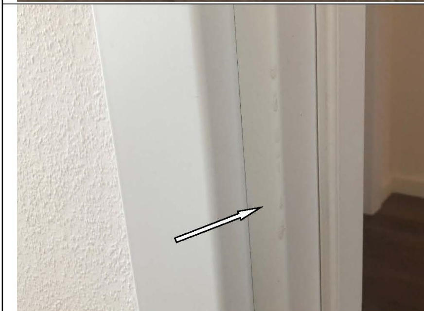
Фото №26. Дефект наличника дверного блока в спальне.
