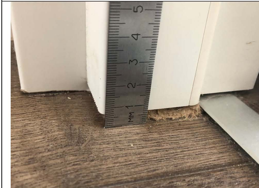
Фото №47. Дефект наличника дверного блока в детской.
