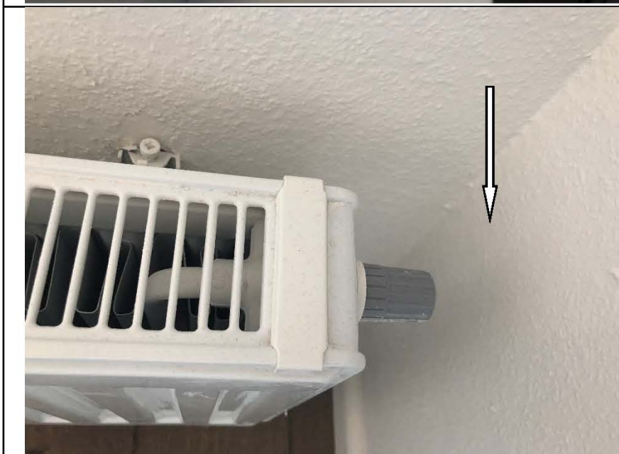
Фото №30. У отопительного прибора в кухне отсутствует регулирующие устройство.
