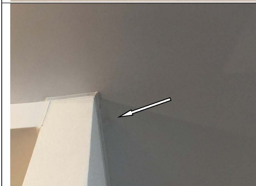
Фото №32. Дефект на натяжном потолке в кухне.
