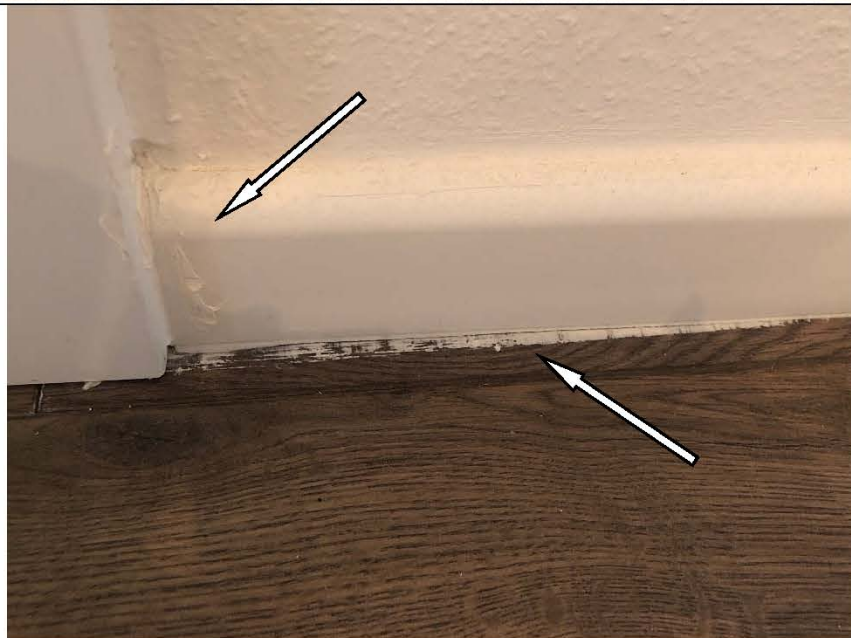
Фото №56. Напольное покрытие в коридоре загрязнено. Загрязнен напольный плинтус.
