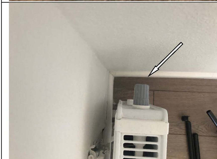
Фото №48. У отопительного прибора в детской отсутствует регулирующие устройство.
