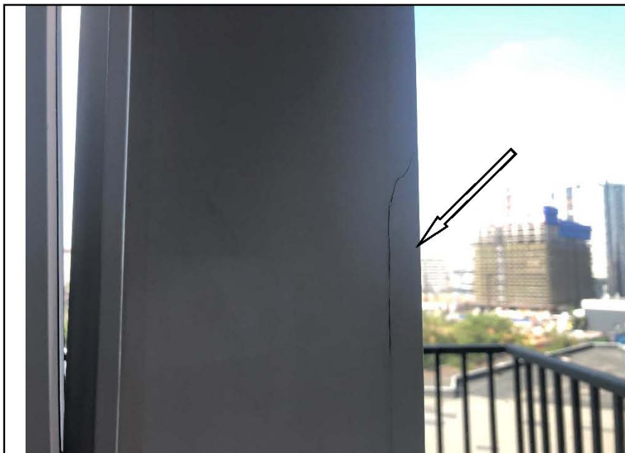
Фото №49. Профиль ПВХ балконного дверного блока в детской имеет трещину.
