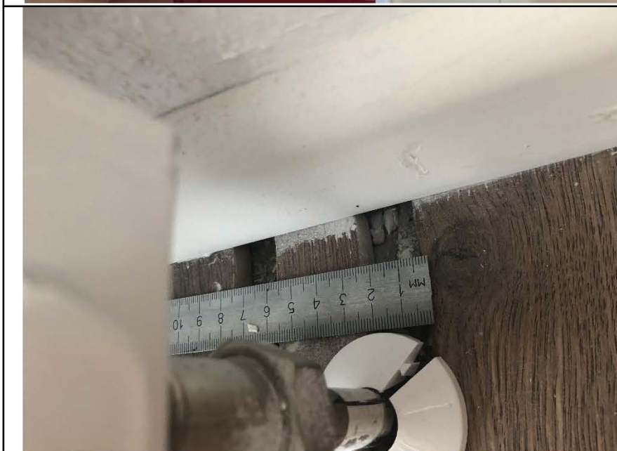
Фото №23. Дефект напольного покрытия в спальне.
