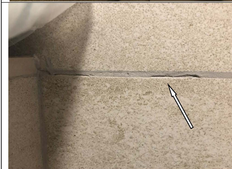
Фото №44. Дефект шва настенной плитки в санузле.
