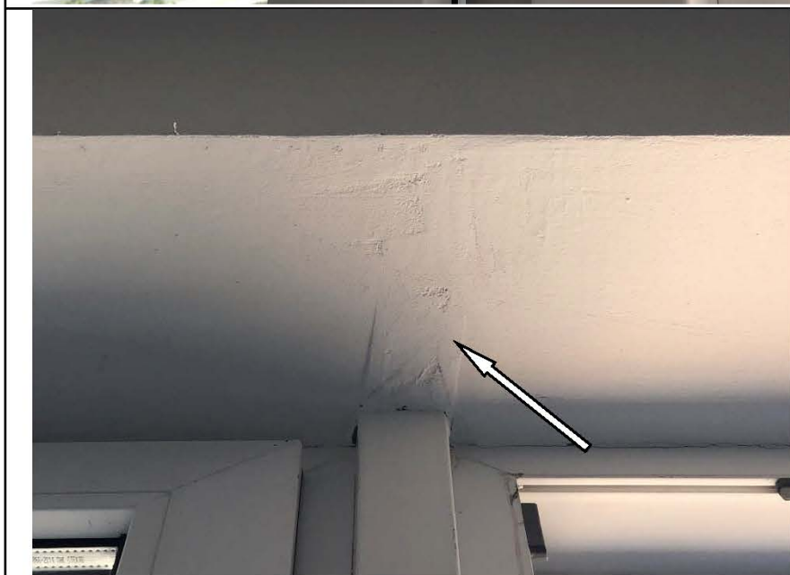
Фото №51. Дефект на откосе оконного блока в детской.
