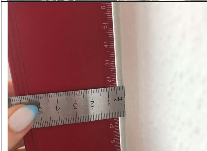
Фото №9. Измерение уровня стен кухни в квартире.
