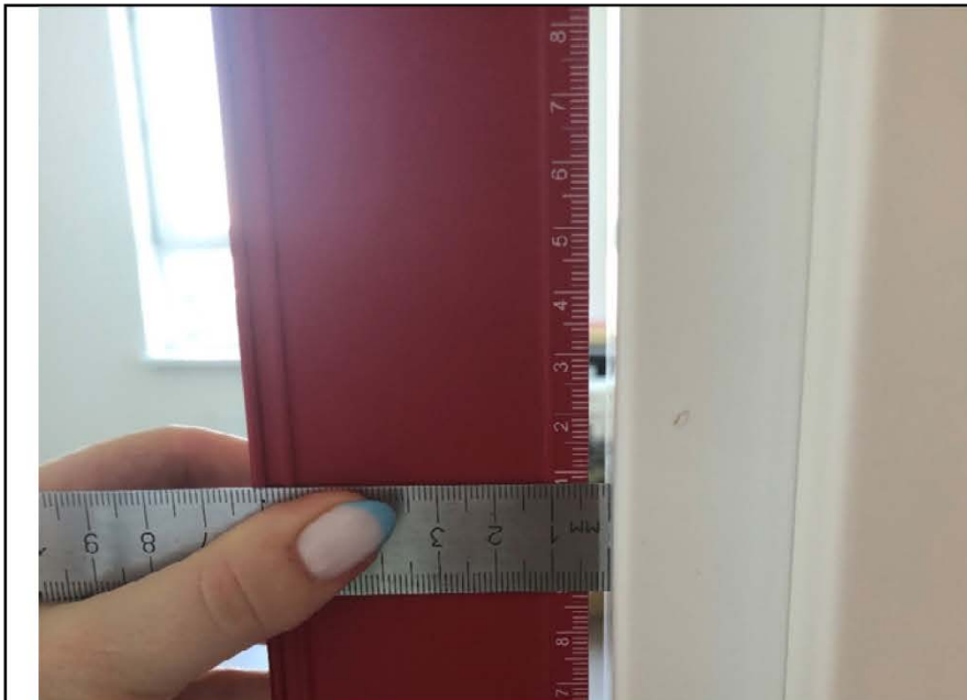
Фото №22. Измерение уровня наличника двери в спальне.
