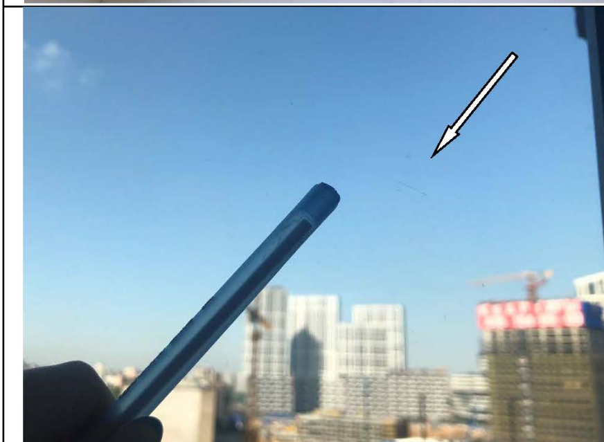
Фото №21. Царапина на стеклопакете оконного блока ПВХ в спальне.
