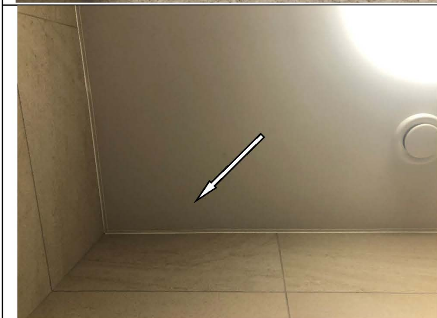
Фото №45. Дефект на натяжном потолке в санузле.
