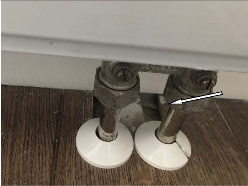
Фото №55. Дефект напольного покрытия в детской.
