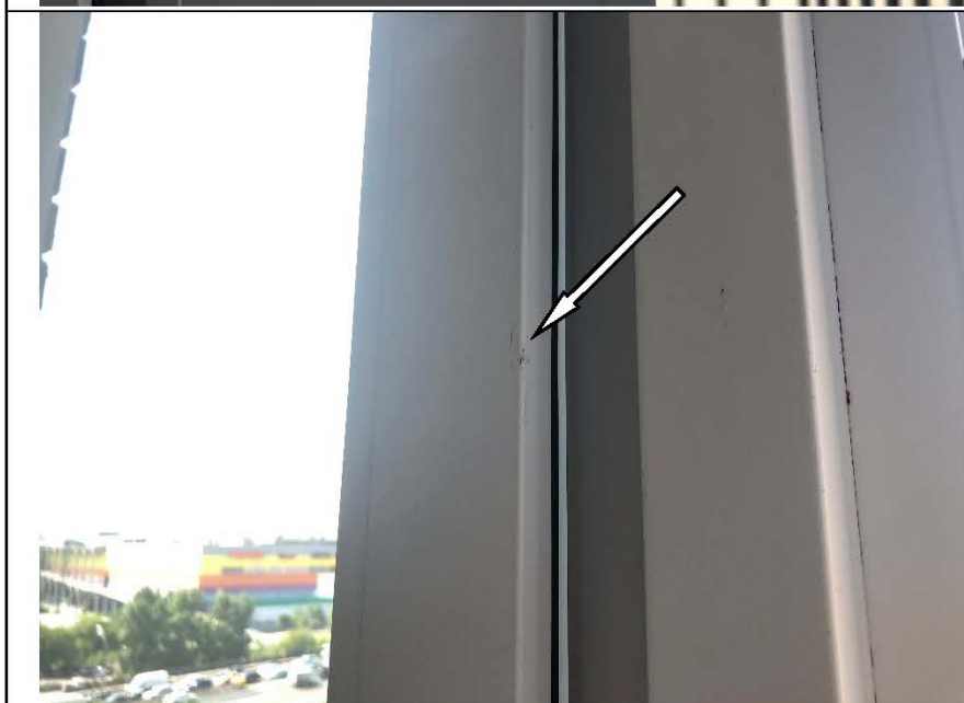
Фото №50. Дефект профиля ПВХ оконного блока в детской.
