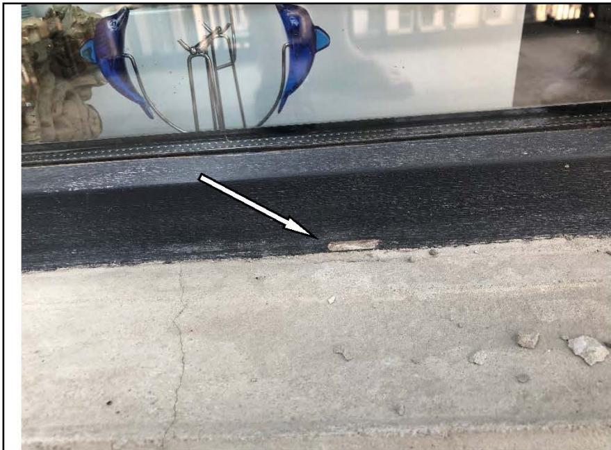
Фото №34. Отверстия в ПВХ профиле балконного блока с оконном для отвода воды в кухне забиты цементным раствором.
